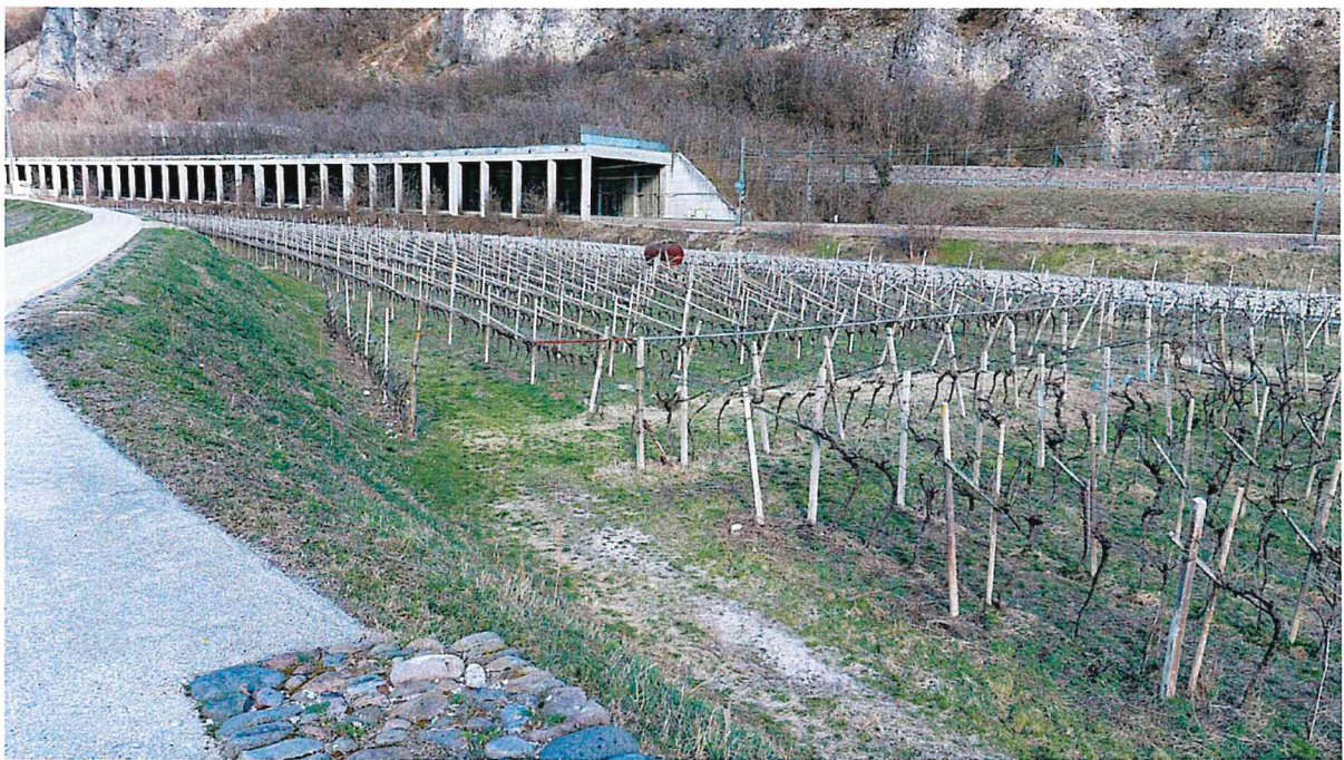
Vista dell'area soggetta alla variante
