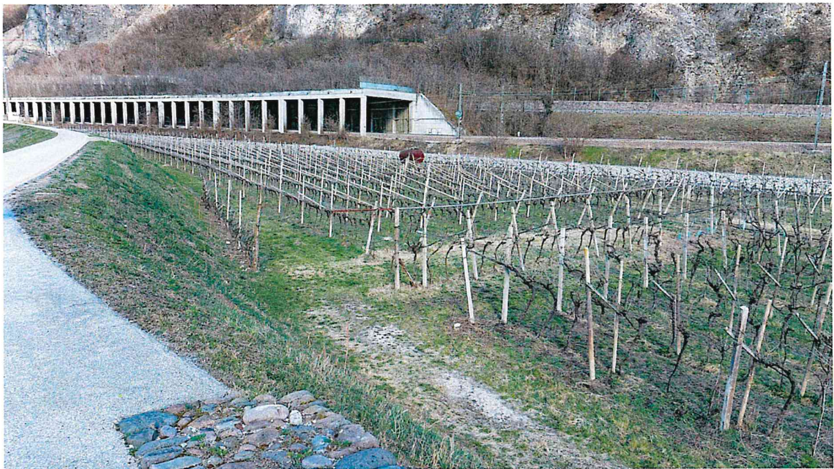
Vista dell'area soggetta alla variante
