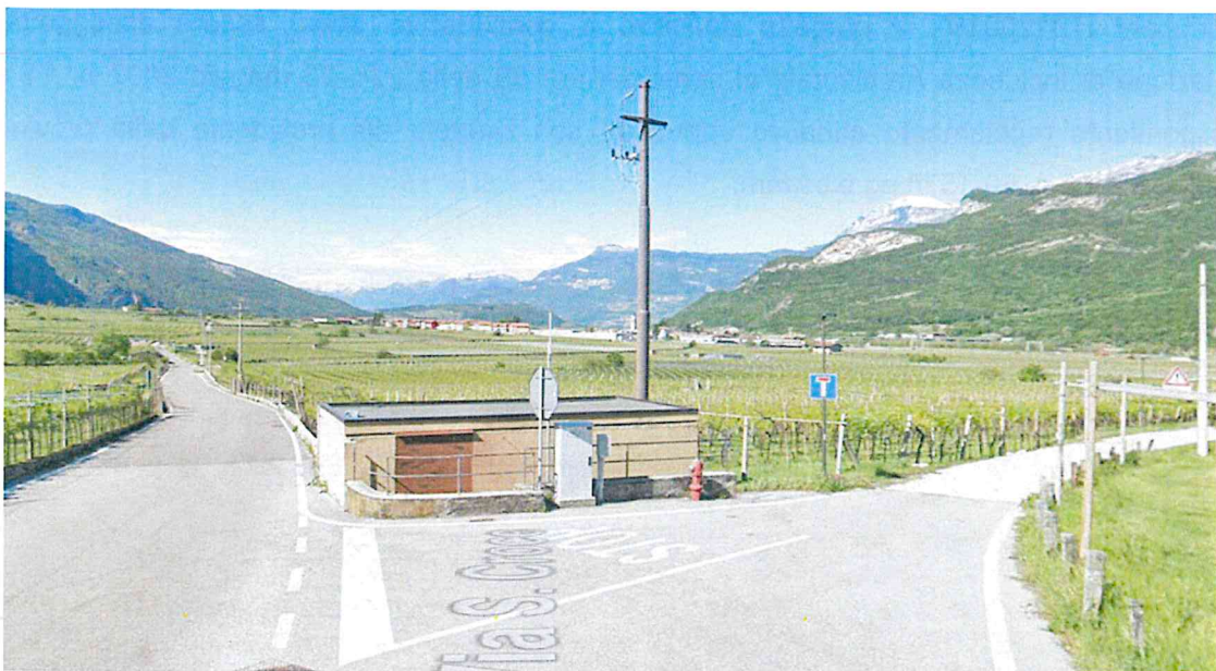
Vista dell'area per la realizzazione della piazzola elicottero (la rete elettrica risulta già spostata)
